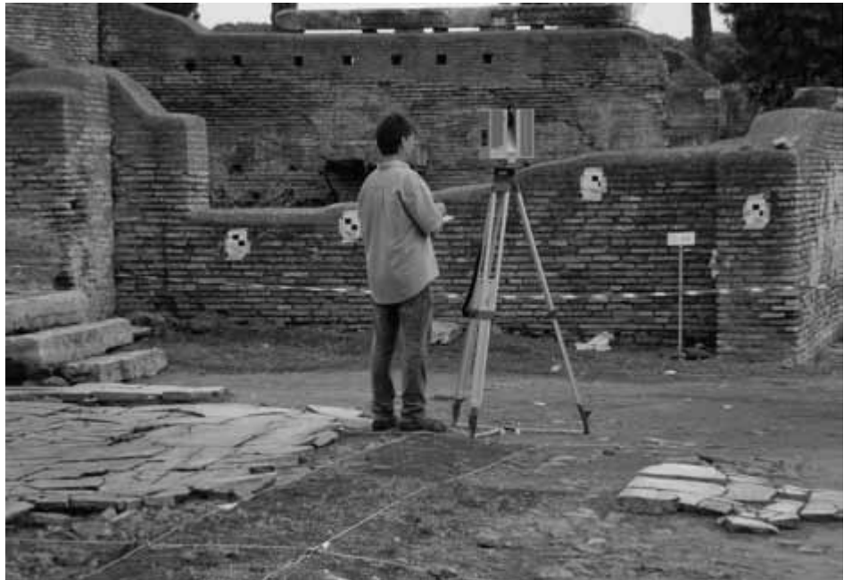
Abb. 48 ,Via della Forica'/Portikus des Forums. Portikuserweiterung des 5. Jhs. bis zum Brunnenraum mit Architrav des Vincentius Ragonius Celsus (Laserscanning)
