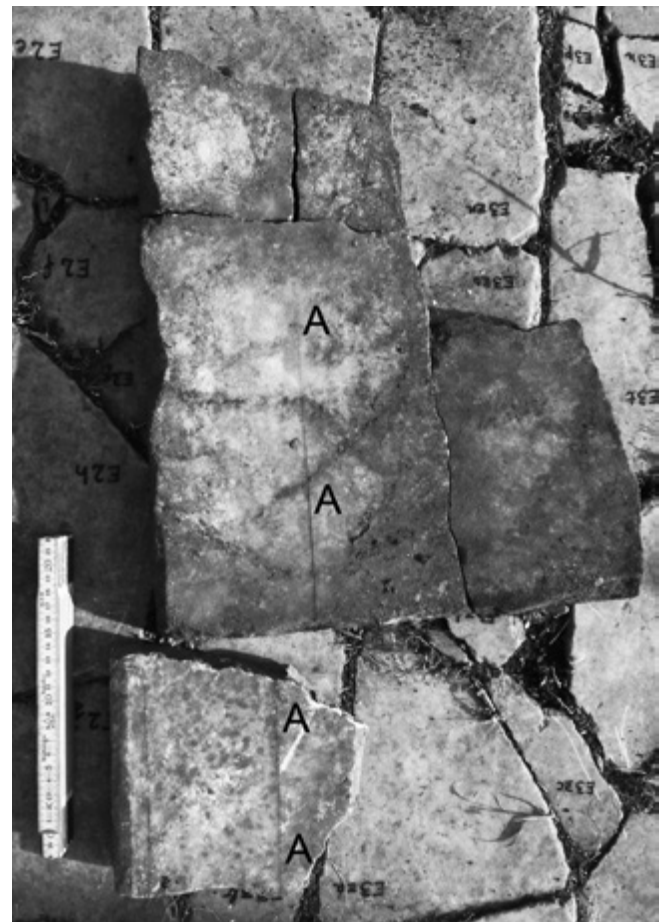
Abb. 10 Die Forumspartikus MFP. Gesägte Bodenplatten mit unregelmäßiger Dicke und Sägespuren (A) von verschiedenen Stellen des spätantiken Pflasters
